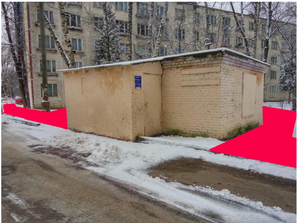
Обход тротуара у строения 10а. По возможности рассмотреть возможность демонтажа указанного строения непонятного назначения
